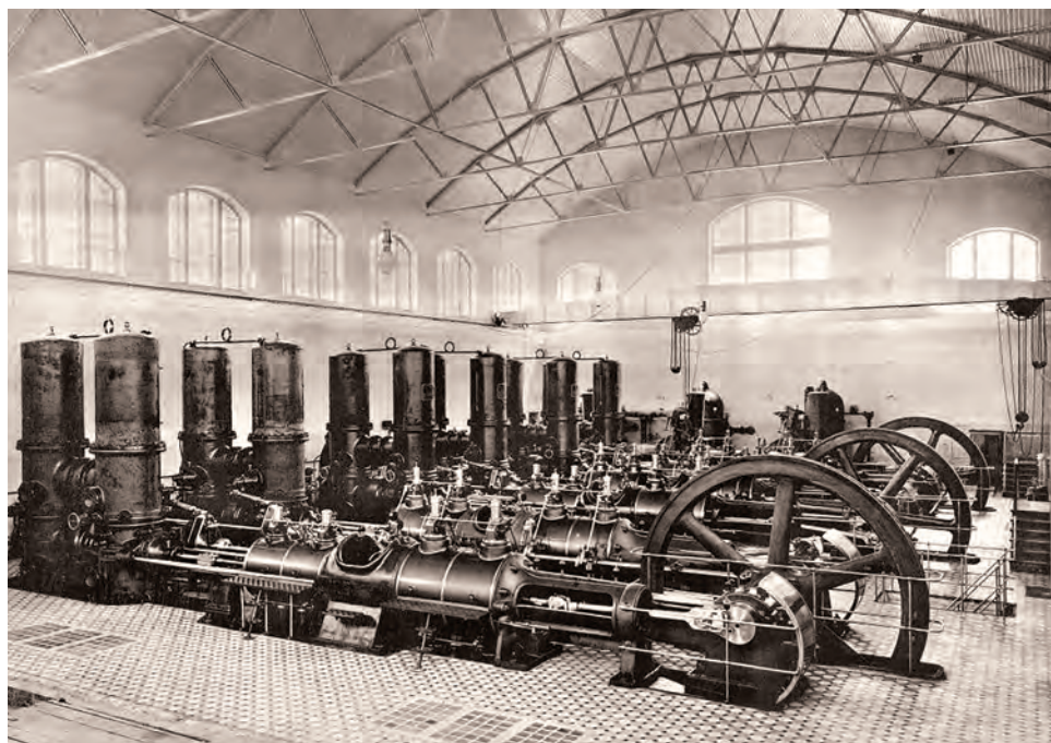
Рис. 20. Машинное здание Рублевской водопроводной станции
