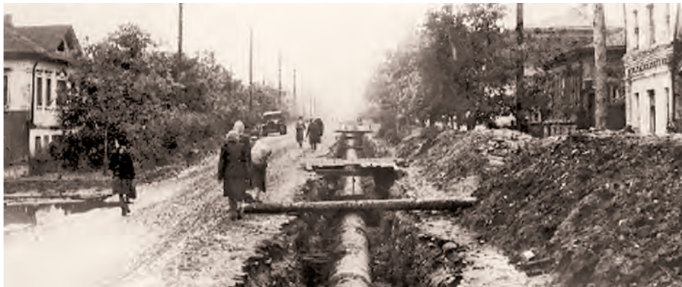
Рис. 22. Строительство водопровода в Екатеринбурге
