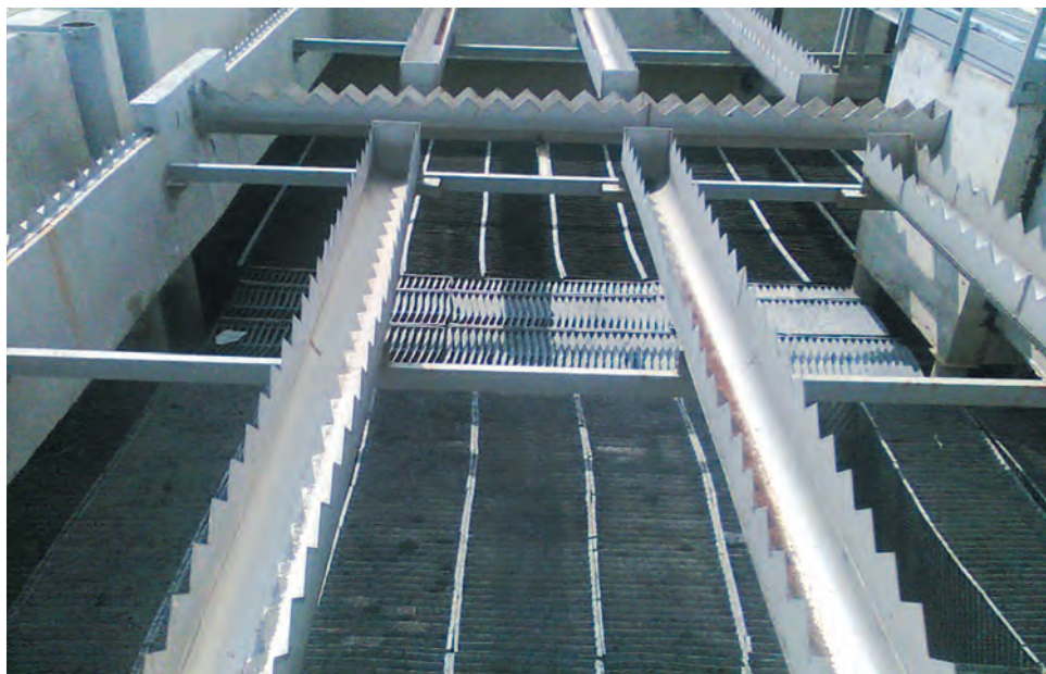
Рис. 42. Горизонтальные отстойники с тонкослойными модулями
