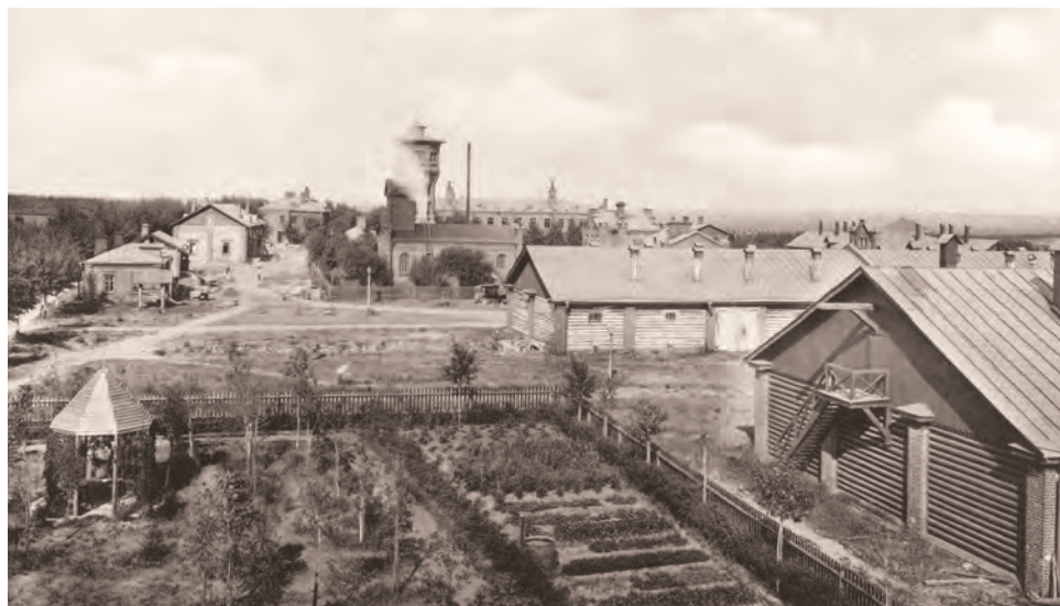
Рис. 13. Люблинская станция аэрации
