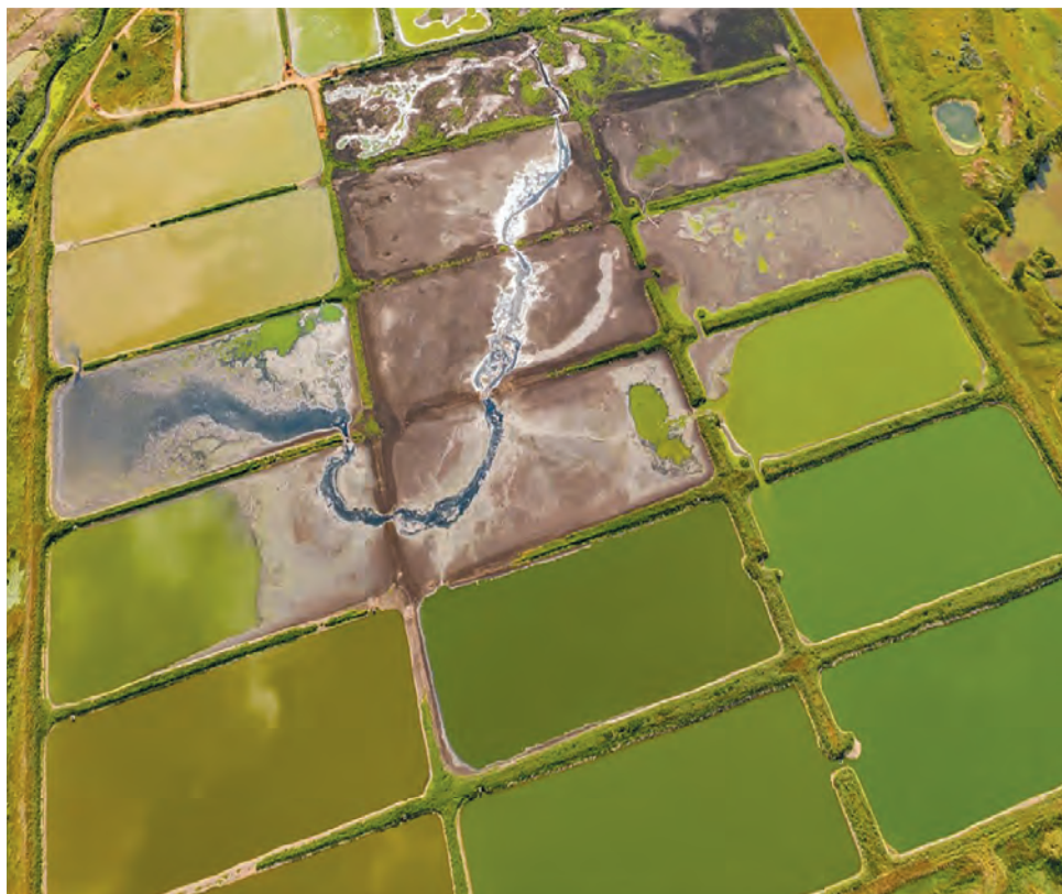
Рис. 64. Иловые площадки канализационных очистных сооружений
