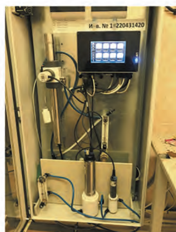
Рис. 36. Типовая система контроля качества воды
