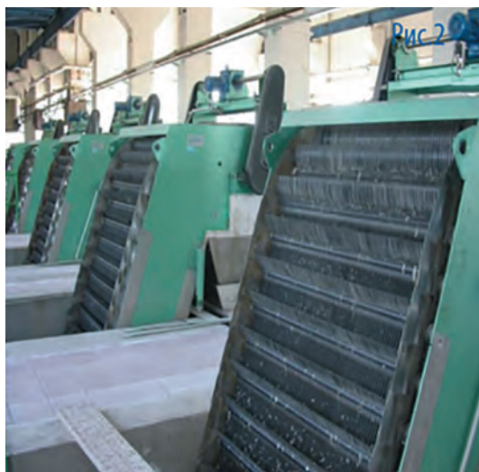
Рис. 55. Этап механической очистки. Решетки
