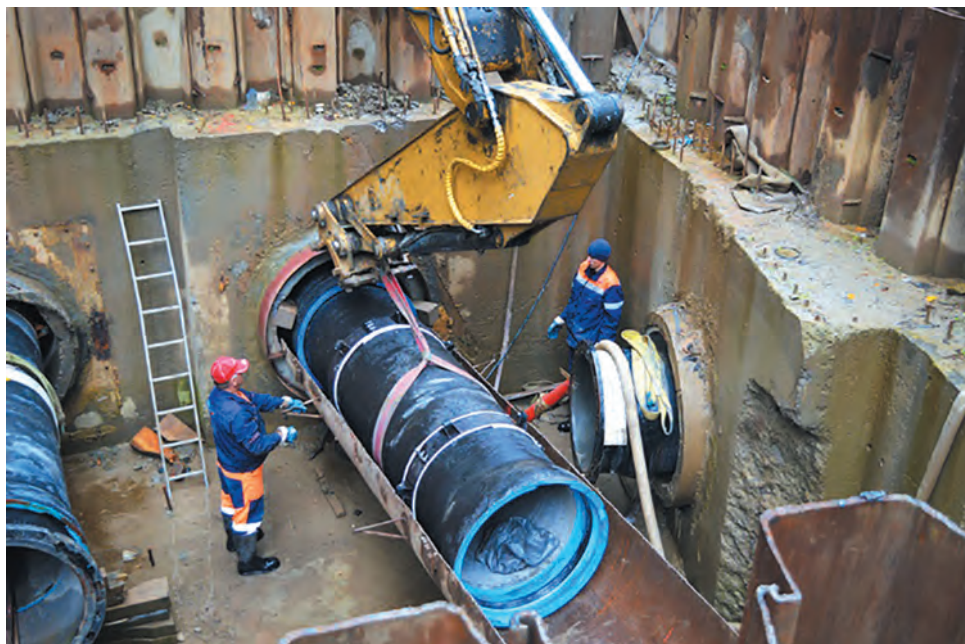
Рис. 31. Прокладка современных трубопроводов
