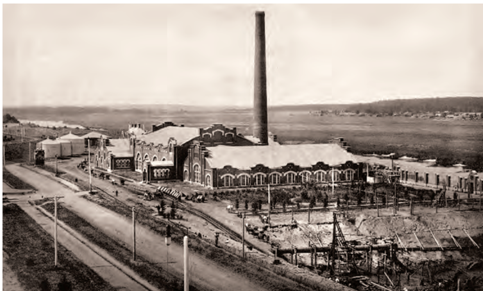
Рис. 19. Рублевская водопроводная станция
