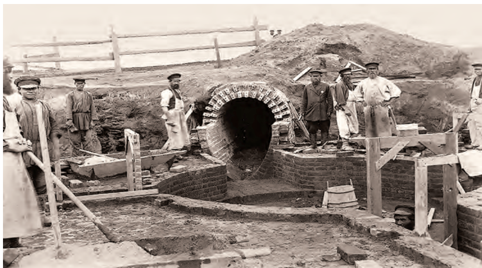
Рис. 10. Строительство канализационного коллектора в окрестностях Москвы
