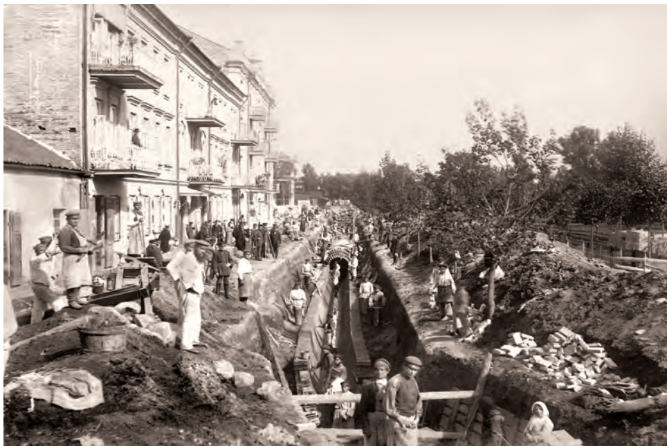
Рис. 12. Строительство канализационной сети в Нижнем Новгороде
