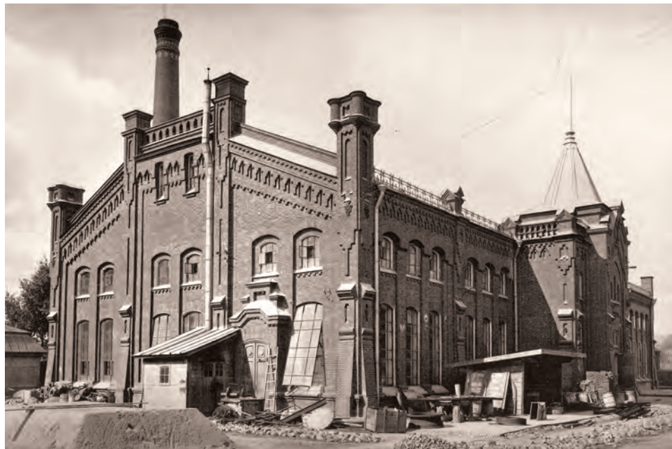
Рис. 8. Здание главной насосной канализационной станции в Москве
