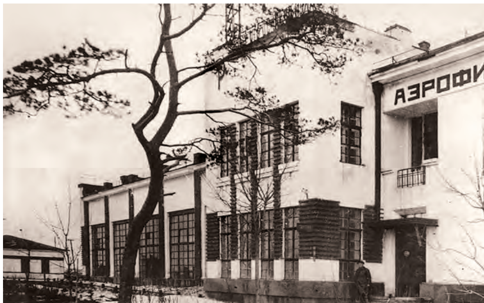
Рис. 11. Кожуховская станция аэрофильтрации
