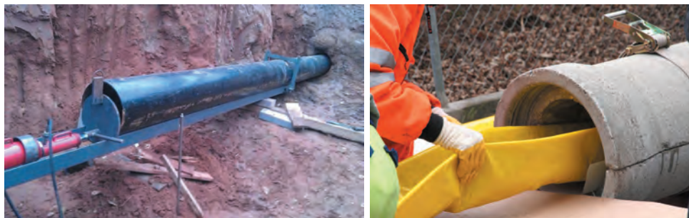
Рис. 15. Бестраншейные методы прокладки трубопроводов
